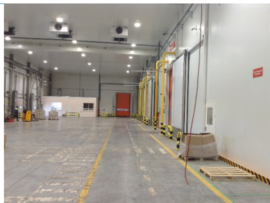
Разгрузочно-погрузочная зона холодного склада
