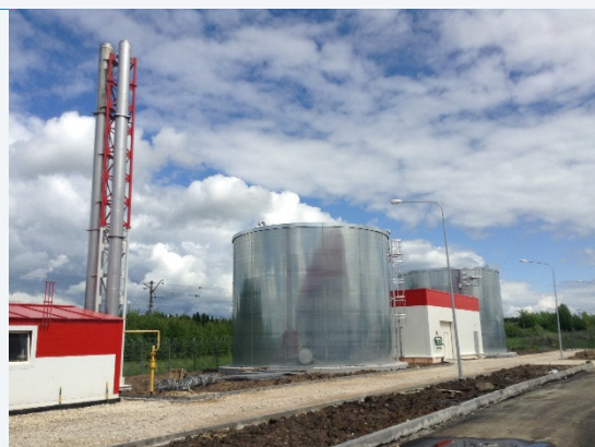
Автономный дизель-генератор и противопожарные емкости
