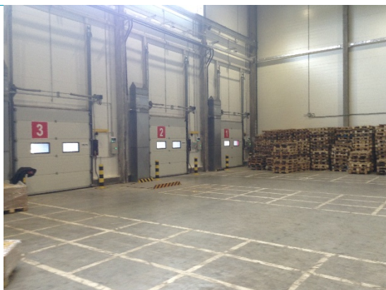
Разгрузочно-погрузочная зона дебаркадеров в теплом части склада
