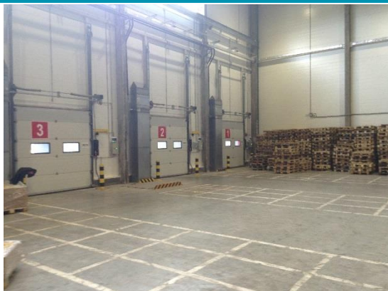
Разгрузочно-погрузочная зона дебаркадеров в теплом части склада
