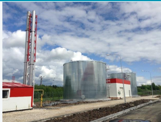
Автономный дизель-генератор и противопожарные емкости
