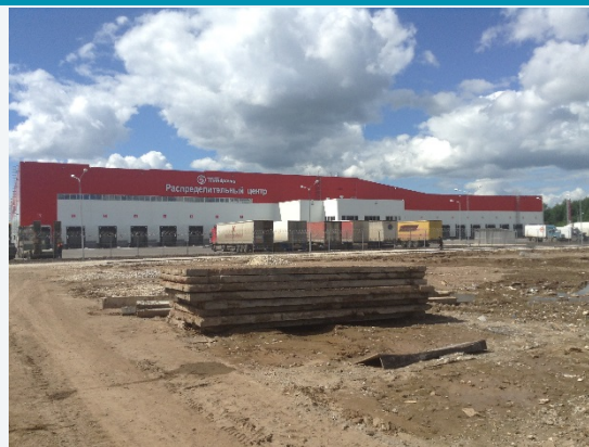
Вид снаружи (корпус распределительного центра)
