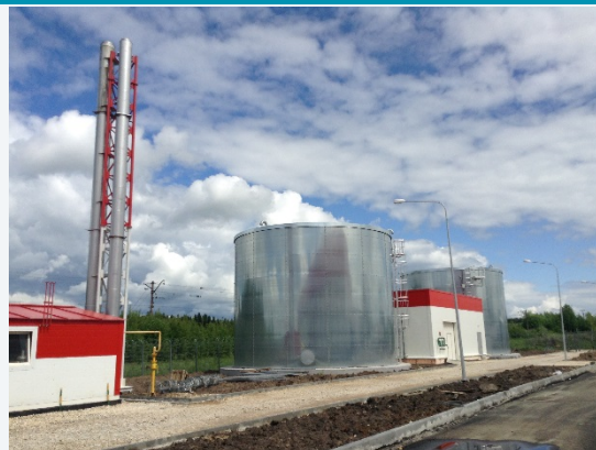
Автономный дизель-генератор и противопожарные емкости
