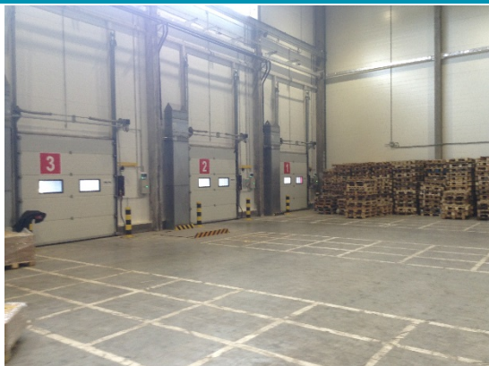
Разгрузочно-погрузочная зона дебаркадеров в теплом части склада
