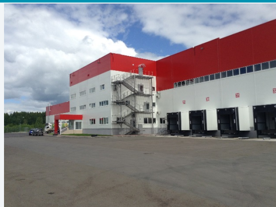
Вид снаружи (корпус распределительного центра со стороны главного въезда)
