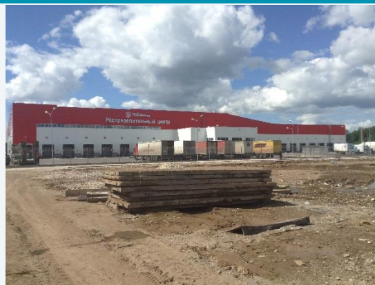
Вид снаружи (корпус распределительного центра)
