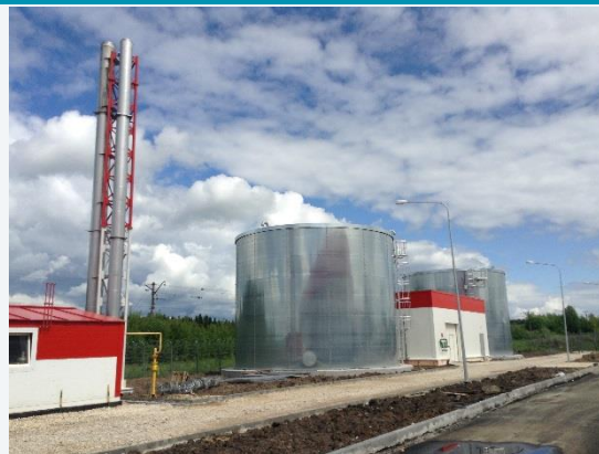
Автономный дизель-генератор и противопожарные емкости
